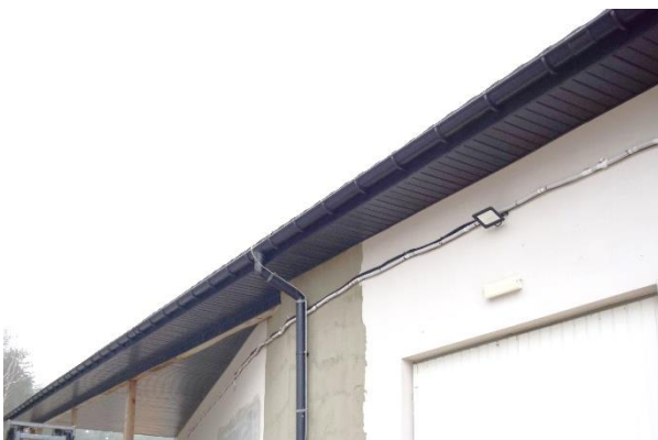
Ryc. 18-21. Fragmenty orywnowań, obróbek blacharskich i podbitek dachowych budynków Centrum Medycznego Zdrowie
