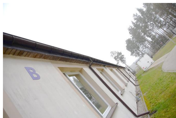
Ryc. 18-21. Fragmenty orywnowań, obróbek blacharskich i podbitek dachowych budynków Centrum Medycznego Zdrowie
