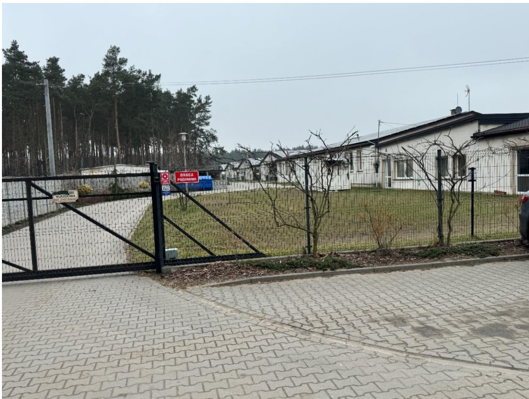
Ryc. 5. Widok obiektów Centrum Medycznego „Zdrowie” Kraszewo-Czubaki od południowej bramy wjazdowej
