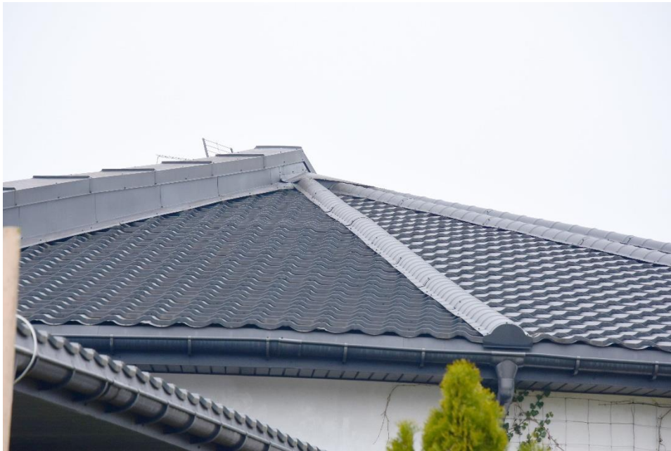
Ryc. 17. Fragment dachu i orywnowania budynku „H” Centrum Medycznego Zdrowie
