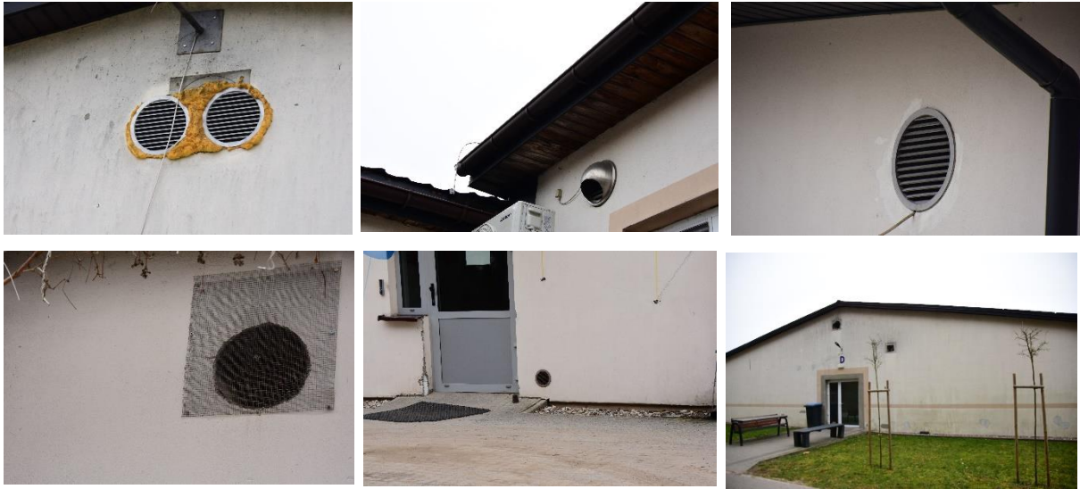
Ryc. 10-15. Osłony otworów wentylacyjnych różnych budynków Centrum Medycznego Zdrowie Kraszewo-Czubaki
