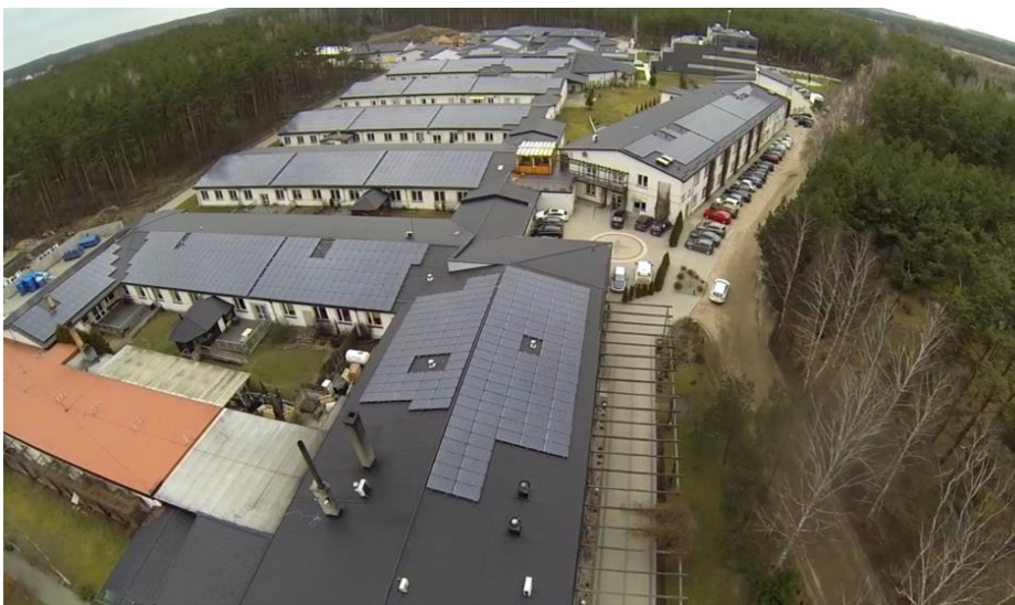
Ryc. 16. Panele fotowoltaiczne na dachach budynków Centrum Medycznego Zdrowie
