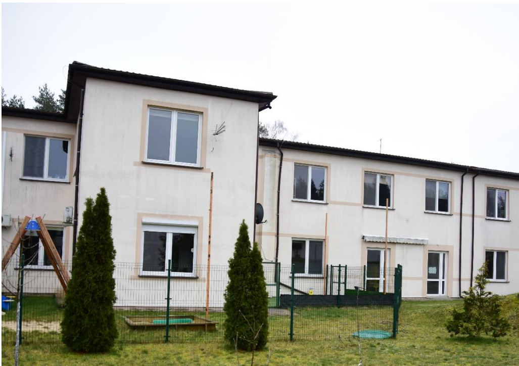
Ryc. 9. Fragment elewacji budynku „F” Centrum Medycznego Zdrowie Kraszewo-Czubaki
