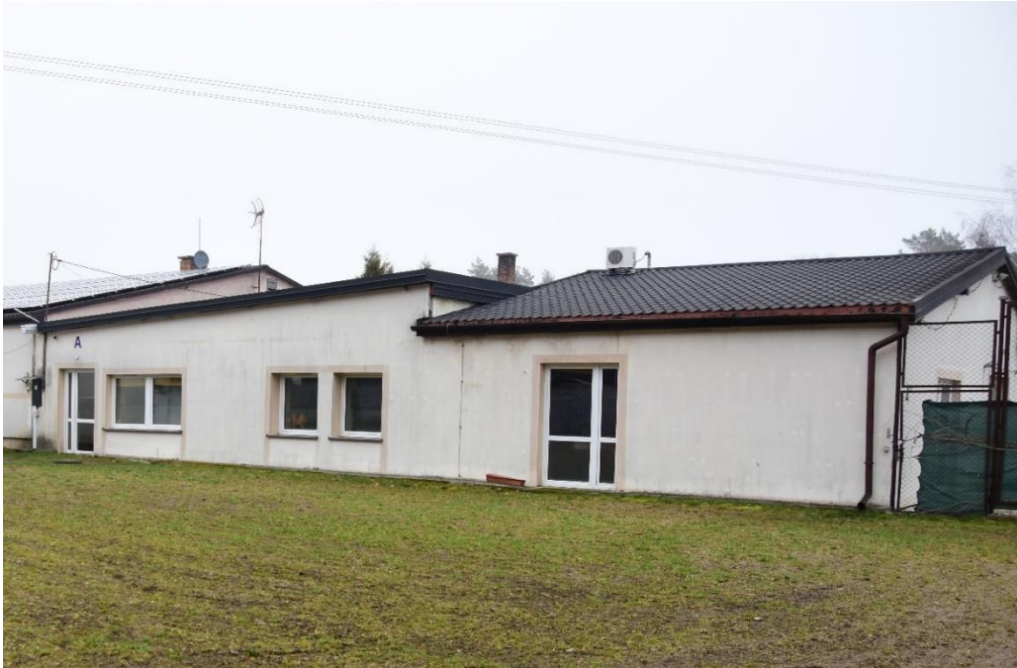
Ryc. 6. Fragment elewacji budynku „A” Centrum Medycznego Zdrowie Kraszewo-Czubaki
